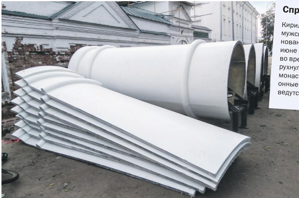
◀ Колонны, выполненные из легкого и прочного материала, снижают нагрузку на кладку
